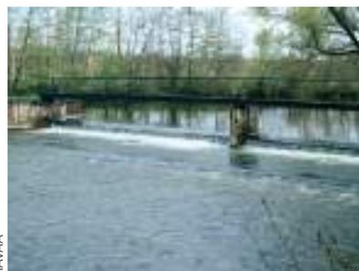
L'ouvrage de Roussy amont avant les travaux, en 2013. À l'origine, le clapet basculant était en position haute en majeure partie de l'année provoquant une chute d'eau supérieure à un mètre.
